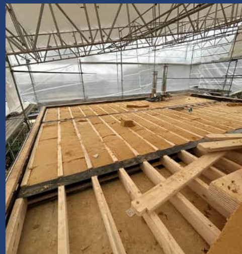
Terrasse en toiture
